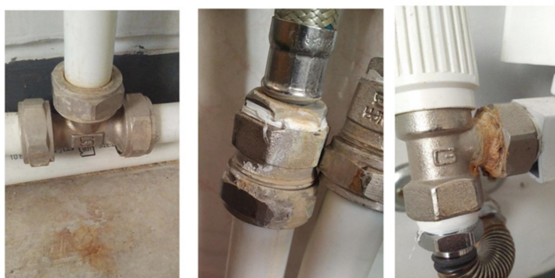
در صورت وجود چنین مشکلاتی مثل تصویر بالا شما مجبور به هوایگیری های مکرر و تنظیم فشار پکیج بصورت مداوم هستید.
